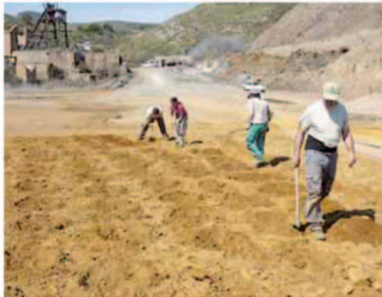
Trabajos en la balsa de la mina Santa Antonieta.
