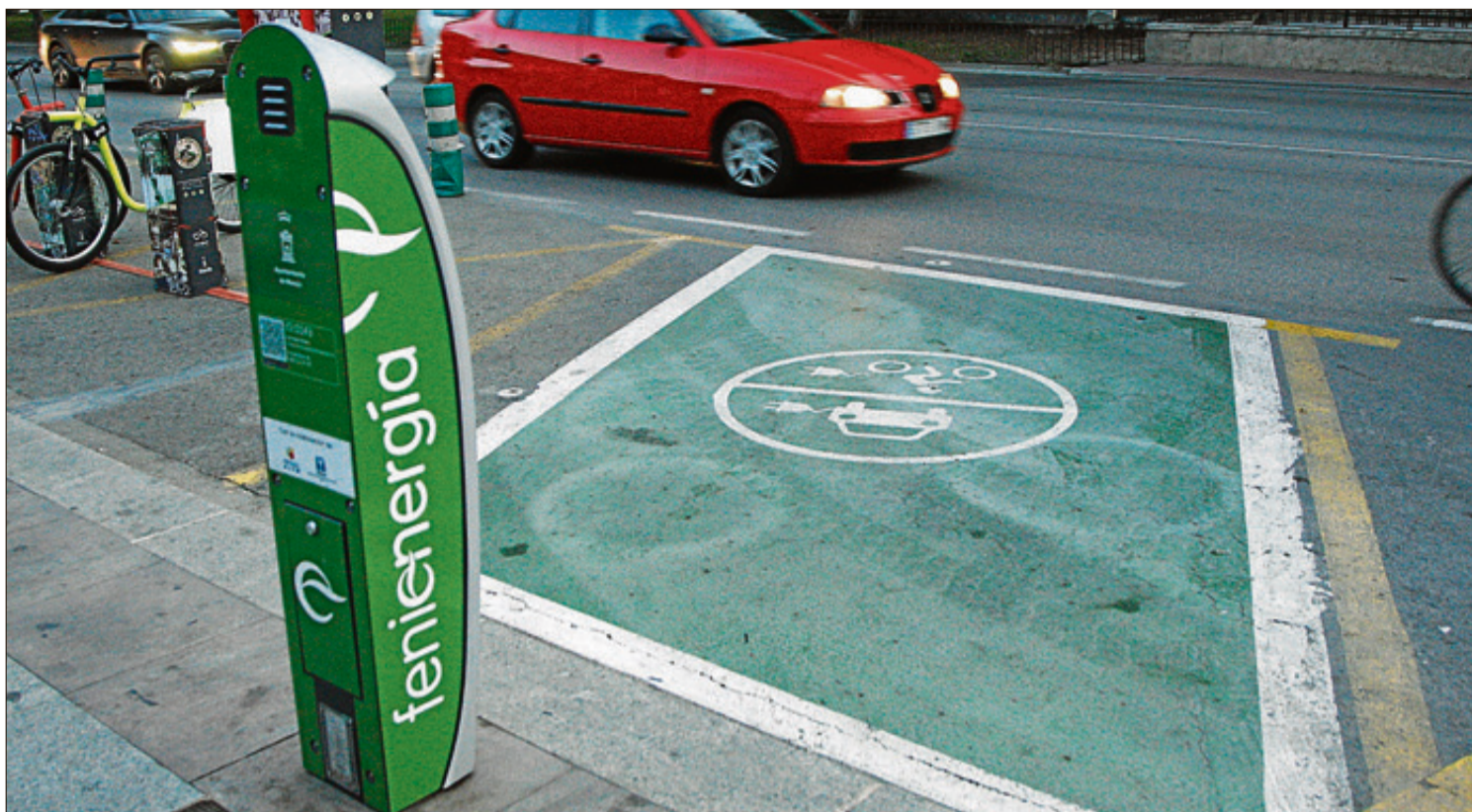
Punto de recarga de coches eléctricos instalado frente al Ayuntamiento de Murcia, en la Glorieta. JUAN CABALLERO
