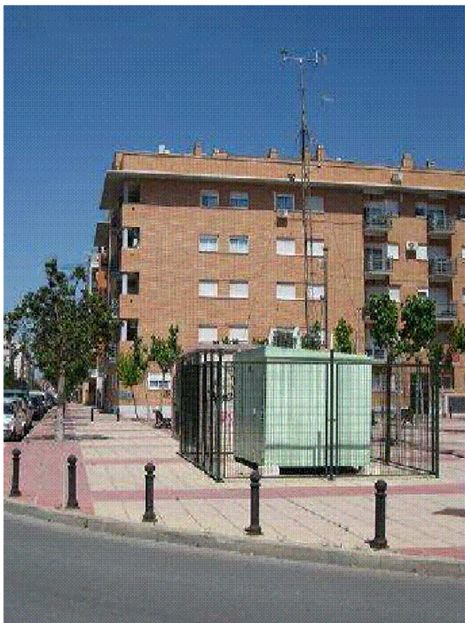
Figura III.13.- Estación de Vigilancia Atmosférica de San Basilio.
