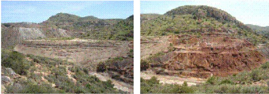
Figura 7.4. Erosión de escombreras por acción del agua.
