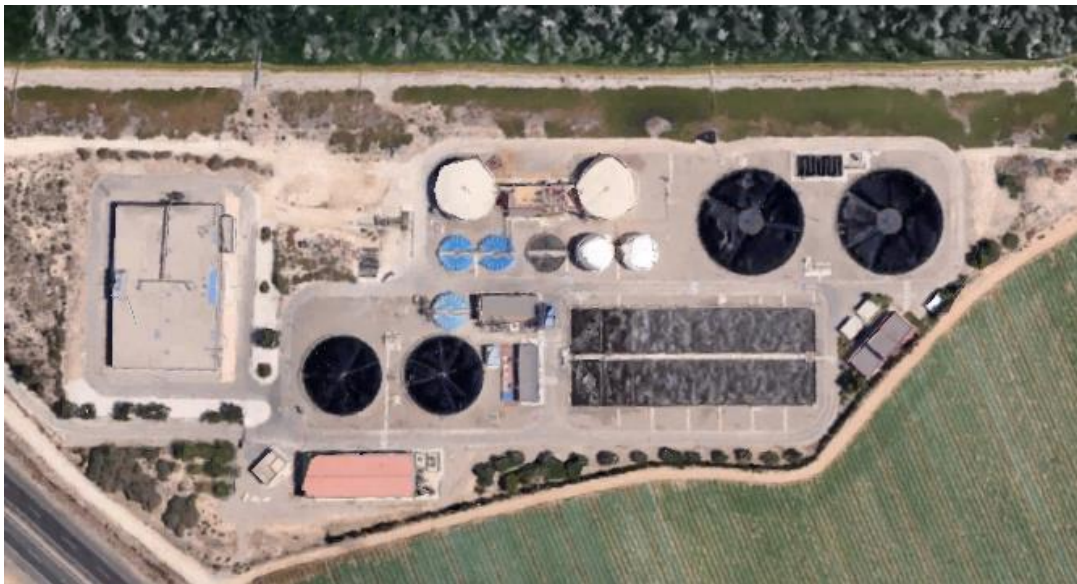
Figura 3.3. Fotografía aérea de la EDAR Cabezo Beza (37° 37'56'' N, 0° 57'09''W)
